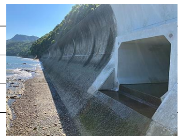
施工例(ボックスカルバート)
